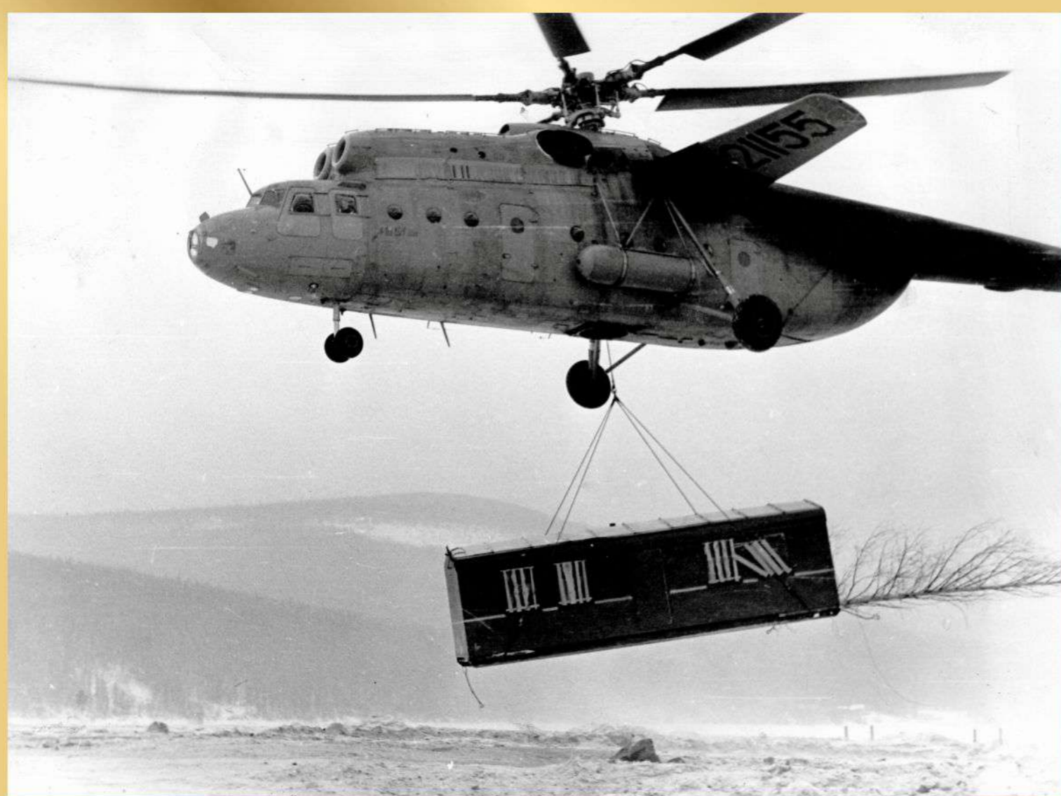
Начало строительства посёлка Магистральный. 1974 год.
