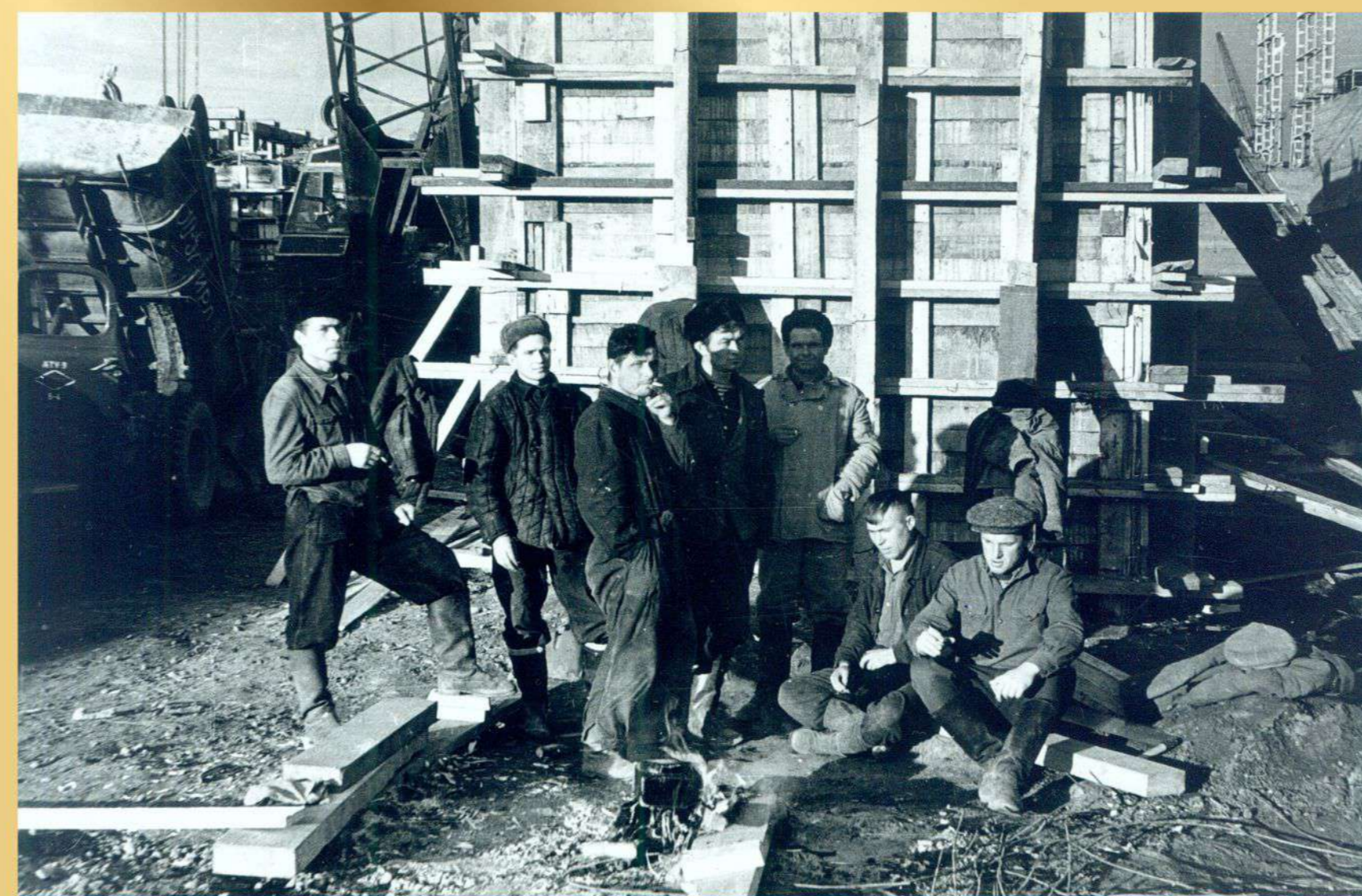
Плотники-бетонщики на строительстве БЛПК. Первый справа – В.В. Игнатов. 1963 год.
